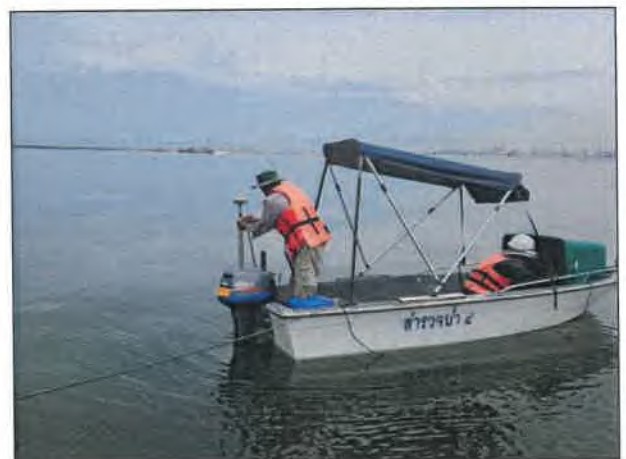
รูปที่ 17 สำรวจค่าระดับพื้นท้องน้ำด้วย ECHO SOUNDING
