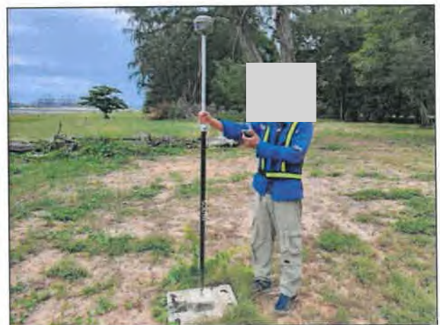
รูปที่ 16 สำรวจค่าระดับพื้นดินด้วย GNSS – RTK
